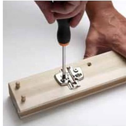
assemblaggio telaio con spine e viti
